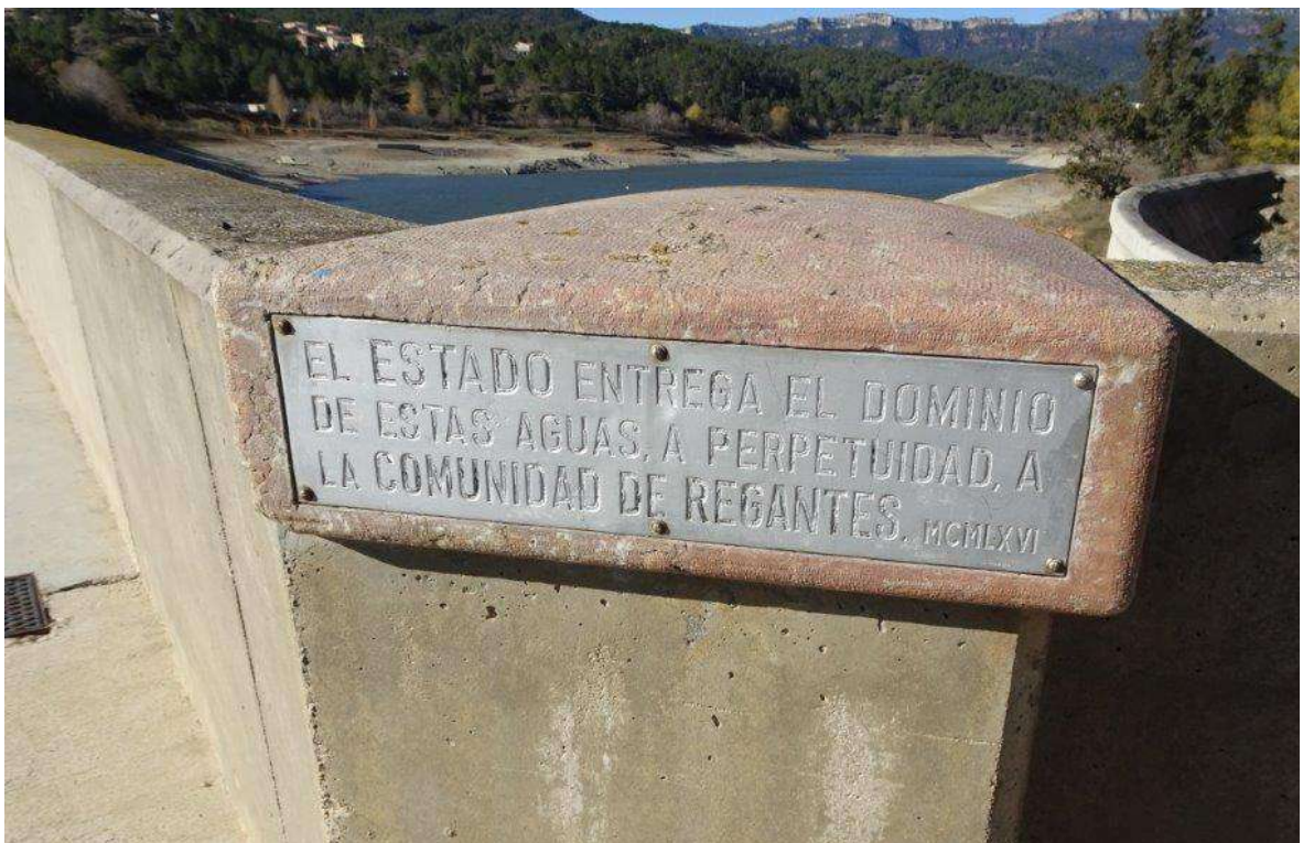
Placa de la paret de la presa de l'embassament de Riudecanyes, el contingut de la qual es contrari a l'establert a la Llei d'Aigües.
